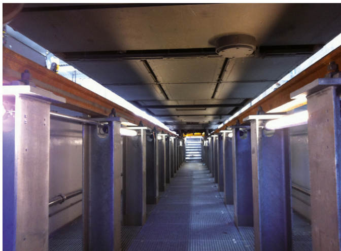
Arbeitsgrubenbeleuchtung ÖBB Revision
