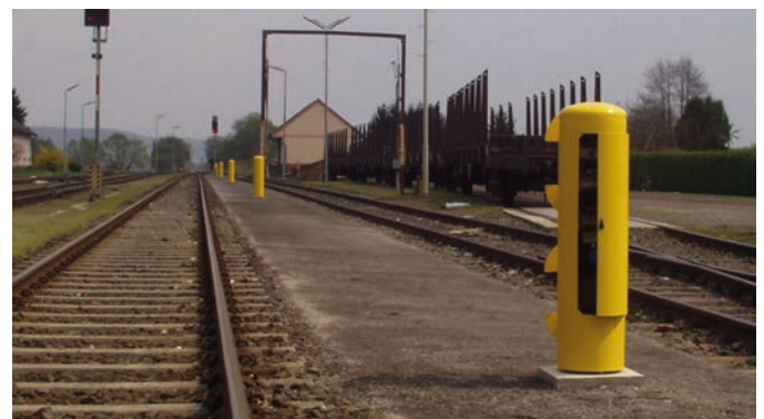
Referenzprojekt: Österreichische Bundesbahnen (ÖBB), Steiermark / Österreich. GIFAS Poller RONDO 300 mit Wickelvorrichtung für Kabel.
