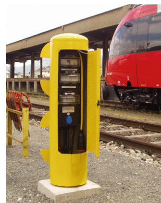
Referenzprojekt: Österreichische Bundesbahnen (ÖBB), Steiermark / Österreich. GIFAS Poller RONDO 300 mit Wickelvorrichtung für Kabel.
