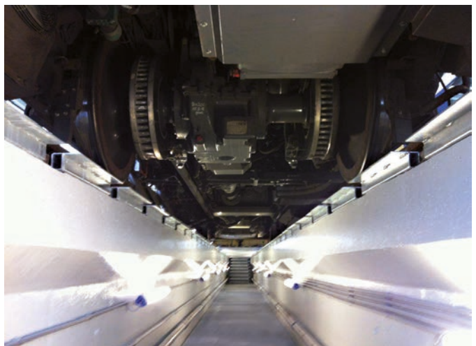
Arbeitsgrubenbeleuchtung ÖBB Traktion
