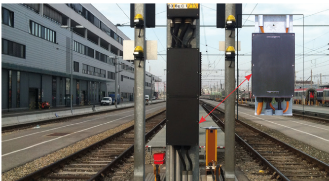
Stützenklemmkasten für Bahnbeleuchtung.
