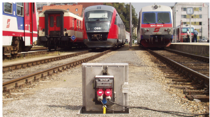
Referenzprojekt: In Linz-Urfahr / Österreich wurde der GIFAS PIAZZA 540 für die Zuganspeisung eingebaut. Wegen des geringen Abstandes zwischen den Gleisen, hat man sich für ein Unterflurenergiesystem entschieden.
