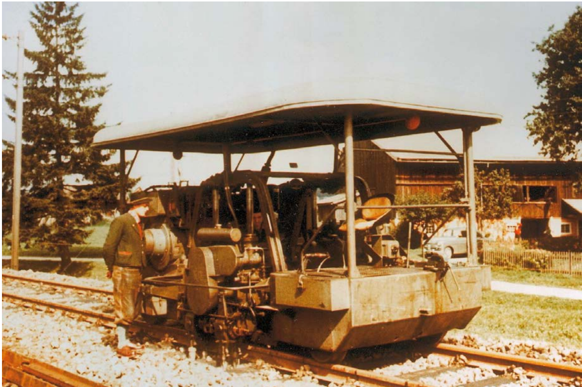
Der Einsatz von Hydraulik ermöglicht die Erfindung der asynchronen Druck-Vibrationsstopfung (1953) Foto: Plasser & Theurer
