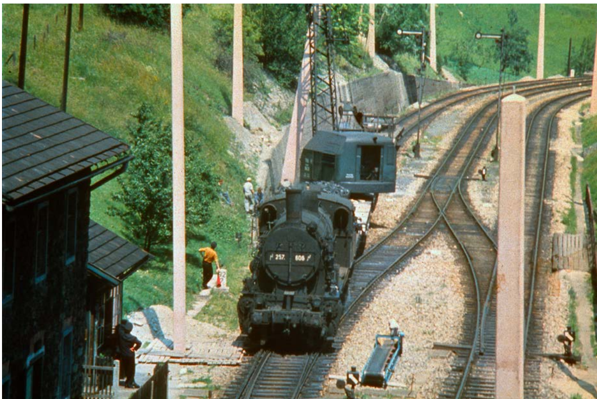
Mastsetzungsarbeiten an der Semmeringbahn, 1958 Foto: Archiv Europten
