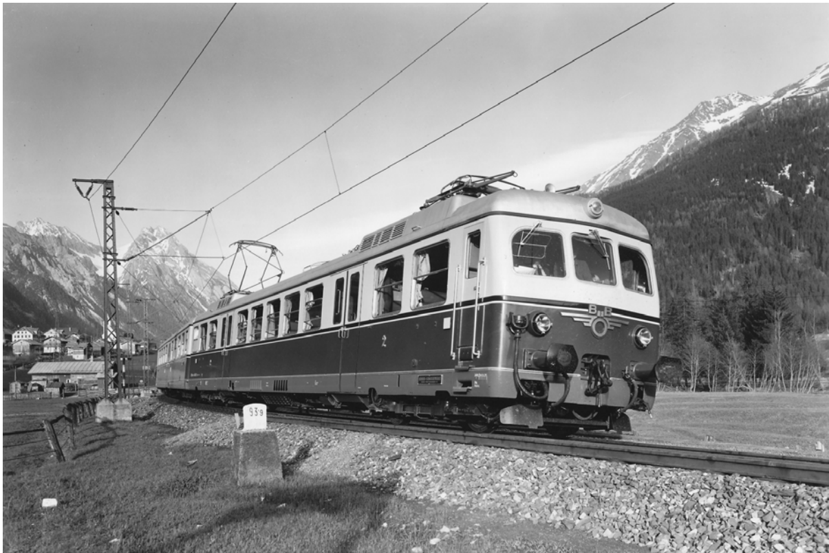
ÖBB Triebwagenschnellzug 4130.02 („Transalpin“ der ersten Generation), Baujahr 1958 Foto: Archiv Siemens
