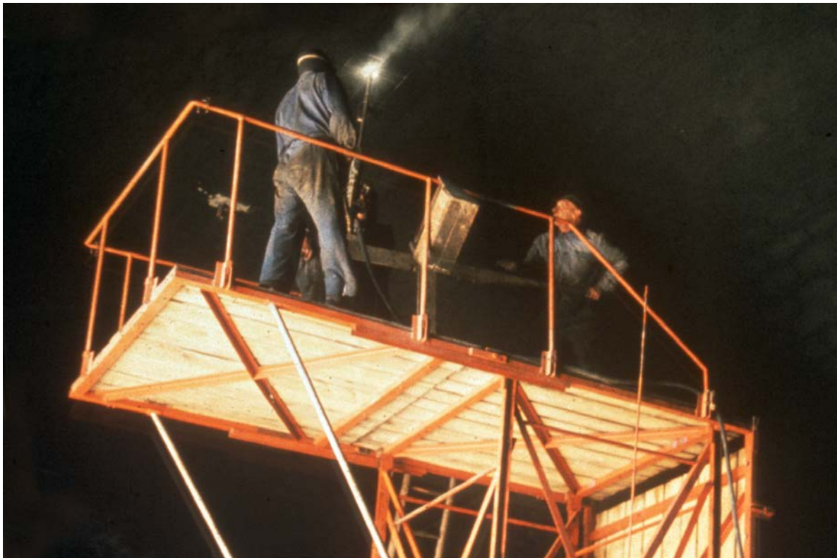
Bohrarbeiten an der Tunneldecke (Semmeringbahn), 1958/59 Foto: Archiv Europten
