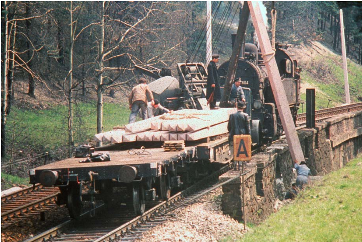
Mastsetzungsarbeiten an der Semmeringbahn, 1958 Foto: Archiv Europten
