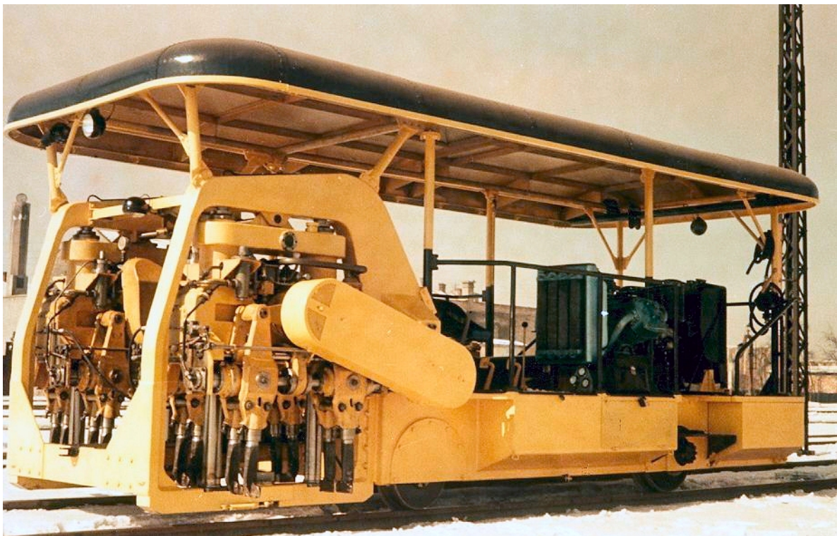
Erste vorkragende Stopfmaschine VKR 01 (1955) Foto: Plasser & Theurer
