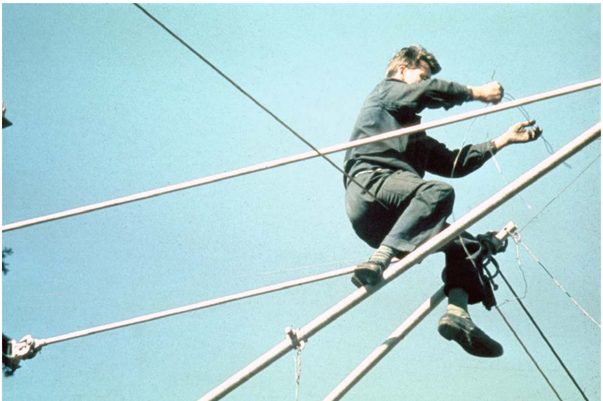
Oberleitungs-Montgearbeiten am Ausleger Foto: Archiv Europten
