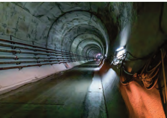
Voestalpine Tubulars sorgt mit hochfesten Rohren für einen sicheren Tunnelvortrieb in einem hochkomplexen geologischen Umfeld.
